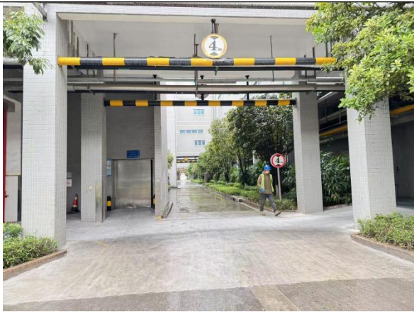
南侧厂区通道
