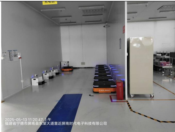
西北侧 AVG 充电区
